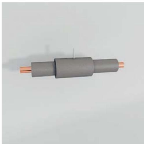
Isolierung größerer Dimensionen anpassen und mit NMC-FIX® dicht verkleben.
