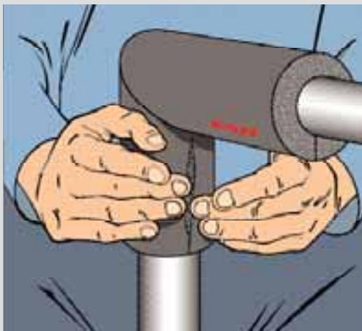
Nachdem die Endstücke des Winkelstücks und des geraden Schlauchs mit Kleber versehen worden sind, fügt man diese aneinander. **7**
