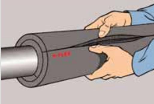
**5** Auflegen der Platte auf die erste Isolierschicht und dabei beachten, dass Nähte versetzt montiert werden.
