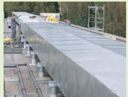
3. Im Außenbereich mit Blech ummanteln. Falls die Alukaschierung als Dampfbremse ausgeführt ist, bitte auf ausreichenden Abstand achten
