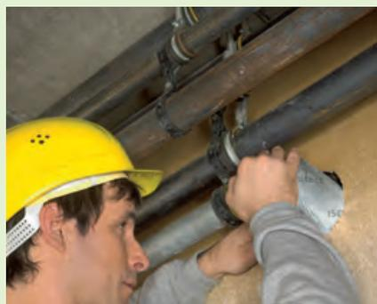
2. Vorteil: kein Produktwechsel. Verlegen Sie die U Protect Pipe Section Alu2 Rohrschale gemäß Prüfzeugnis, auch im Durchbruch.
