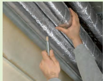
3. Fixieren Sie die CLIMCOVER Lamella Mat gemäß DIN 4140, z. B. mit Bindedraht bzw. bei Brandschutzanwendungen gemäß Prüfzeugnis.
