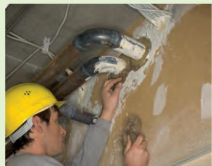
3. Verschließen Sie unregelmäßige Durchbrüche gemäß Prüfzeugnis, brandsicher und rauchdicht z.B. mit Mörtel.
