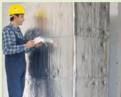
2. Verkleben Sie die Fugen und Stöße dampfdicht.
