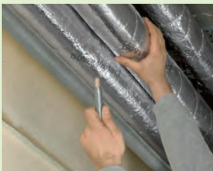
1. Fixieren Sie die U Protect Pipe Section Alu2 Rohrschale gemäß Prüfzeugnis.
