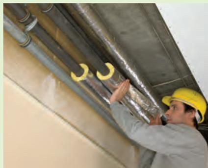
2. Kleben Sie an Fugen und Stößen sorgfältig ab, damit die Aluminiumkaschierung als Dampfbremse wirken kann.
