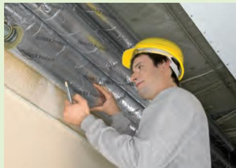
2. Fixieren Sie die U Protect Pipe Section Alu2 Rohrschale abschließend gemäß DIN 4140, z. B. mit Bindedraht bzw. bei Brandschutzanwendungen gemäß Prüfzeugnis.
