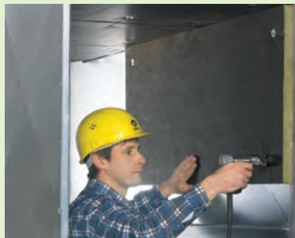
2. U TECH Slab MT 3.1 V2 wird im Kanal mechanisch nach DIN 4140 bzw. alternativ mit  $9\text{ Pins/m}^2$  unter der Kanaldecke und an den Seiten und auf dem Boden mit  $6\text{ Pins/m}^2$  Dämmstofffläche angebracht.
