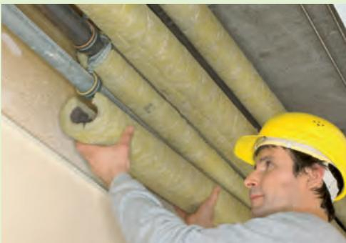
U TECH Pipe Section MT 4.0: einfach und schnell verlegt. Wichtig: fixieren Sie die ISOVER Rohrschale gemäß DIN 4140, z. B. mit Bindendraht.
