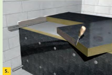
**5. Dämmung und Abdichtung.** Verstreichen Sie den ISOVER Protect BSK Brandschutz-Kleber (Dicke ca. 2 mm) gleichmäßig auf der Wand und der Stirnseite der Platten. Verkleben Sie die Platten mit der Wand, um Undichtigkeit infolge der Ausdehnung des Stahlkanals im Brandfall zu vermeiden.
