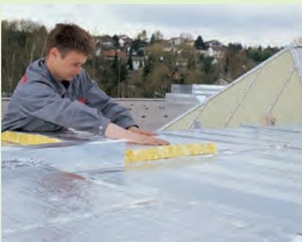
1. Fixieren Sie die Lamellenmatten CLIMCOVER Lamella Mat gemäß DIN 4140 z. B. mit Pins und Clips.
