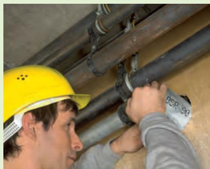
2. Protect Pipe Section BSR 90 Alu2 wird per Selbstklebeband verschlossen und mit Drahtwicklungen fixiert.
