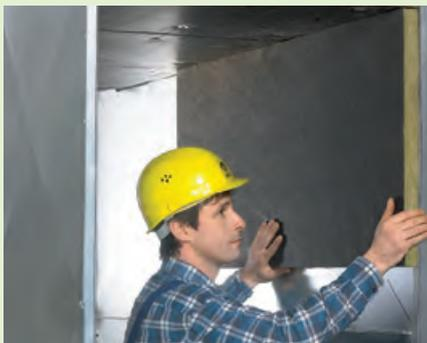
1. U TECH Slab MT 3.1 V2 stumpf stoßen und fugenversetzt anordnen.
