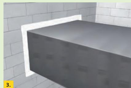
**3. Abdichtung des Durchbruchs.** Bestreichen Sie auf beiden Seiten die Oberfläche des Durchbruches deckend mit Protect BSF Brandschutzfarbe, um den Durchbruch rauchdicht zu verschließen. Nutzen Sie einen Spachtel, um eine Schicht von circa 2 mm Dicke aufzutragen.
