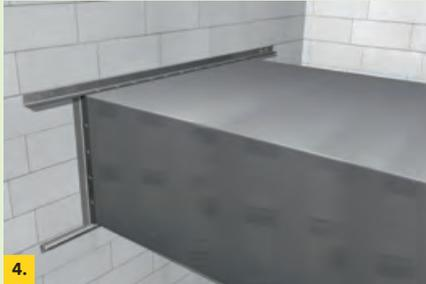
**4. Verstärkung des Kanals.** Rahmen Sie den Kanal mit L-Profilen (30 x 30 x 3 mm) auf beiden Seiten der Wand ein. Die L-Profile werden mit Stahlnieten (3,2 x 10 mm) am Kanal befestigt ( $c \leq 100$  mm). Das obere und untere Profil wird jeweils mit 2 Wandankern/Dübeln an der Wand befestigt.
