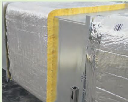
2. Alternativ können Sie die Lamellenmatten CLIMCOVER Lamella Mat mit Spannbändern pro Meter gemäß DIN 4140 fixieren.
