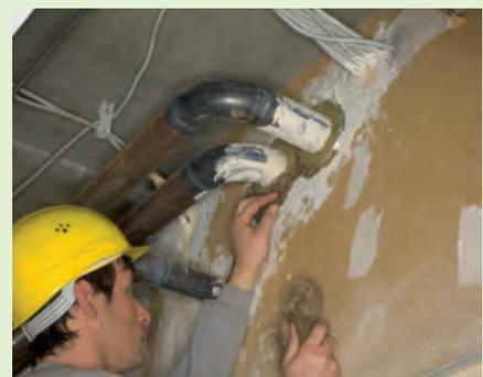
3. Verschließen Sie unregelmäßige Durchbrüche einfach mit Protect BSW lose Brandschutzwolle brandsicher und rauchdicht.
