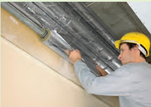
1. Verkleben Sie die Aluminiumfolie an Fugen und Stößen dampfdicht, damit die Kaschierung als Dampfbremse wirkt.
