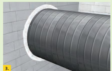
**3. Abdichtung des Durchbruches.** Bestreichen Sie auf beiden Seiten die Oberfläche des Durchbruches deckend mit Protect BSF Brandschutzfarbe, um den Durchbruch rauchdicht zu verschließen. Nutzen Sie einen Spachtel, um eine Schicht von circa 2 mm Dicke zu bekommen.
