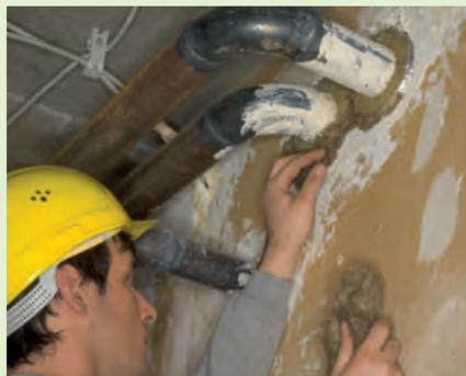
So verschließen Sie mit Protect BSW unregelmäßige Durchbrüche in F90-Massivwänden oder F120-Decken einfach und sicher.
