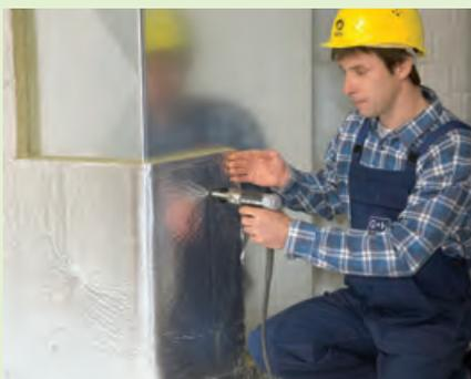
1. Verlegen Sie U TECH Slab MT 3.1 Alu1 dicht gestoßen und fugenversetzt. Befestigen Sie die Platten mechanisch mit Pins und Clips nach DIN 4140.
