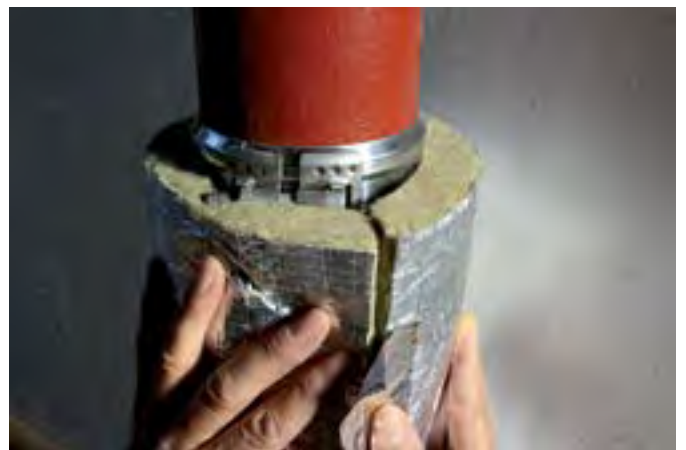
Montage der ROCKWOOL Klimarock
