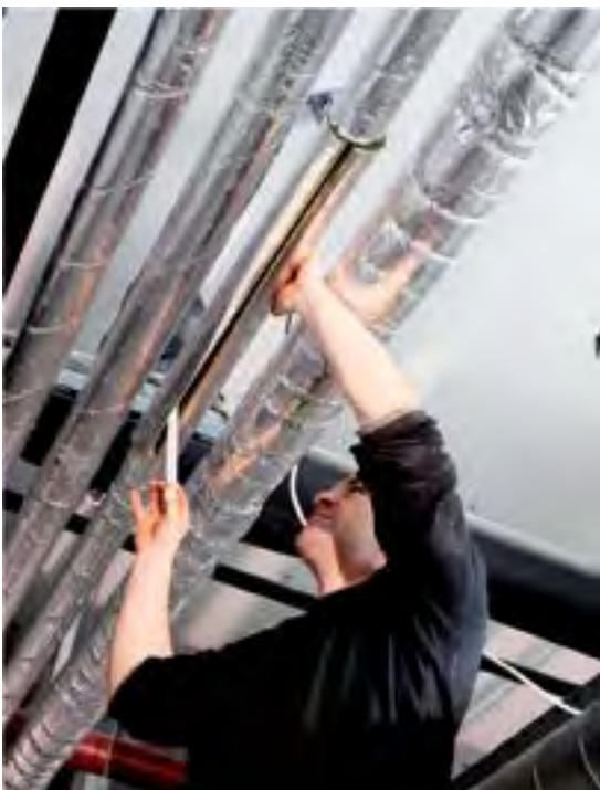
Montage der ROCKWOOL 800 an Heizungs- und Trinkwasserleitungen
